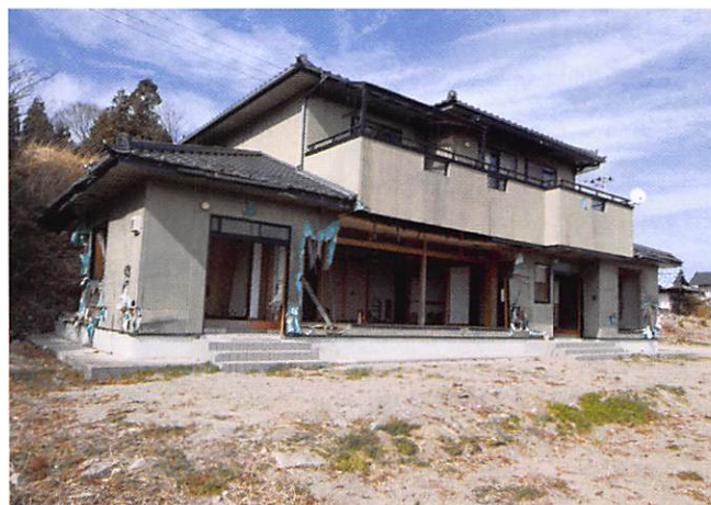
津波で1階部分が崩壊した家
