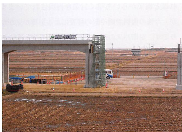
山元町では常磐線の高架による復旧工事が行われていた
