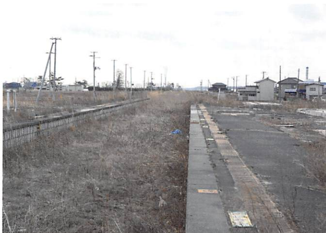
旧 JR 山下駅跡。線路や信号機なども撤去された
