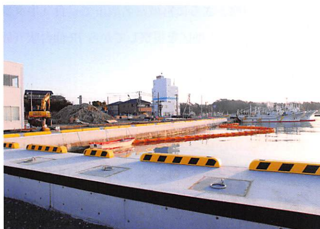
漁港の改修工事。奥に「みなとや」さんが見える
