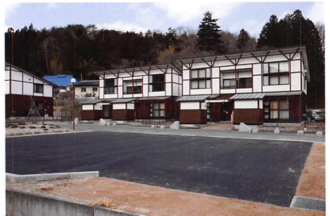
飯館村の住宅 除染で駐車場がきれいになっている
