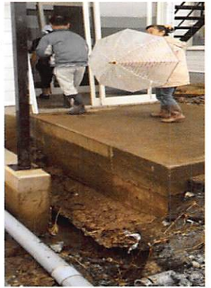
玄関前の地面が大きく抉られている
