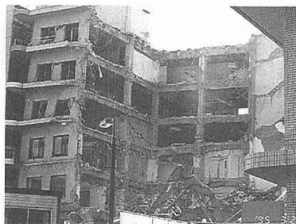
崩壊した西市民病院の解体作業
