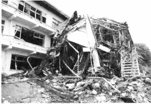
破壊力と集積力を示す瓦礫の山
