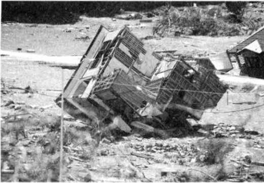
2階から上部を引きちぎり放り投げられた家
