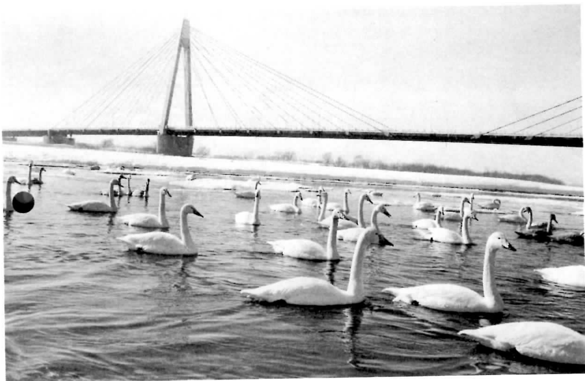
十勝中央大橋
