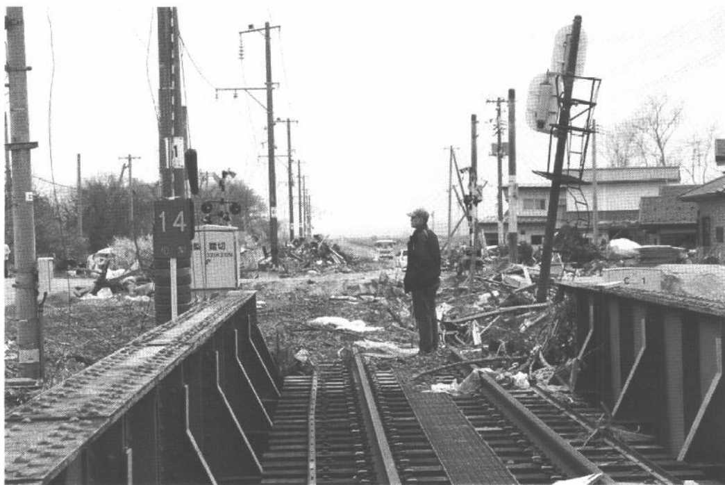
宮城県亘理郡山元町 山下駅付近
